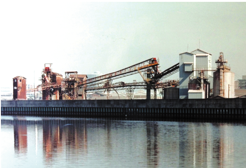
関西で最初の生コン工場である大阪セメント佃工場
